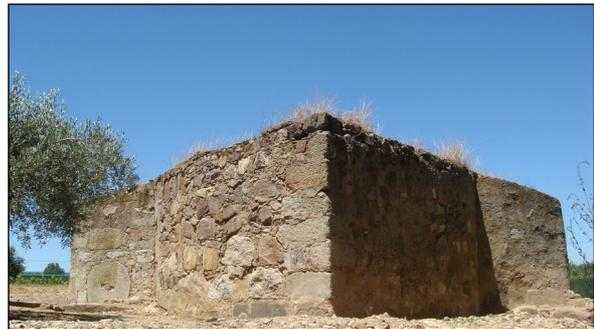
de encarar la fuerza de la corriente y distribuirla hacia ambos lados, termina la construcción hacia oriente con forma de tajamar – *“Parte de fábrica que se adiciona a las pilas de los puentes, aguas arriba y aguas abajo, en forma curva o angular, de manera que pueda cortar el agua de la corriente y repartirla con igualdad por ambos lados”* -.
